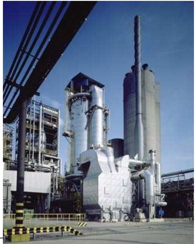
Figura 1: Vista del sitio previa al incidente.
