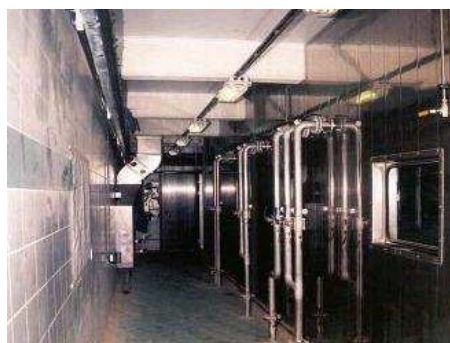
• Vista exterior del recinto revestido de acero (DR)
